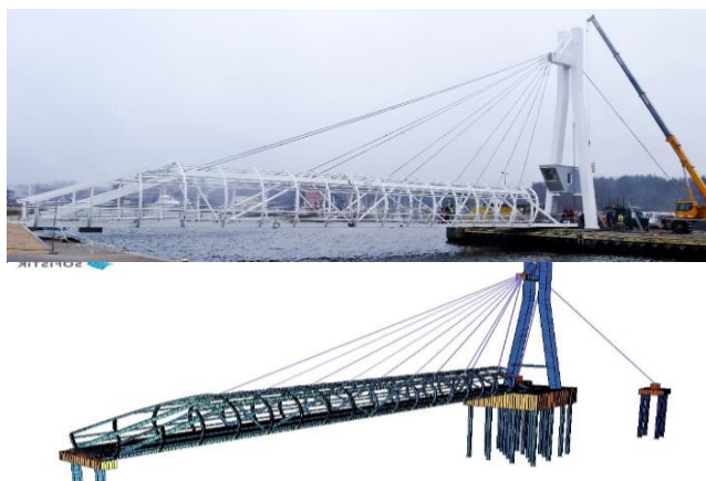
Rys. 3. Obrotowa kładka dla pieszych nad kanałem portowym w Ustce – rzeczywistość i model MES
