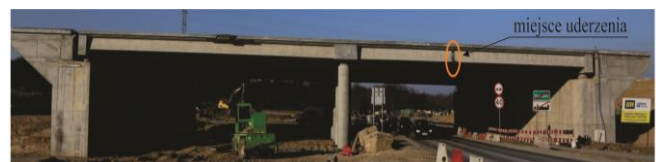
Rys. 1. Wiadukt drogowy WD 113
