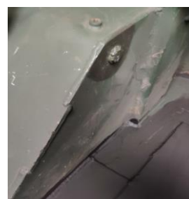
Rys. 8. Połączenie zamkowe
