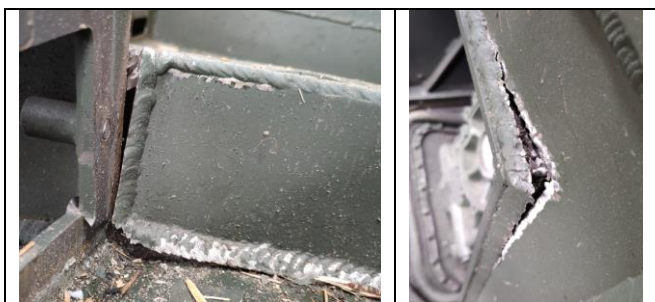
Rys. 5. Uszkodzenia spoin łączących poszczególne elementy konstrukcji nośnej
